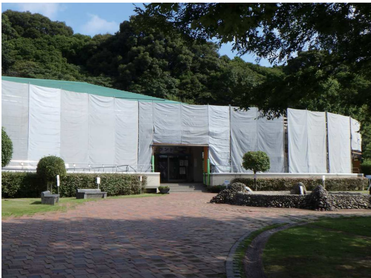
ぎょぎょランド外壁工事 (2019 年 1 月下旬まで)
